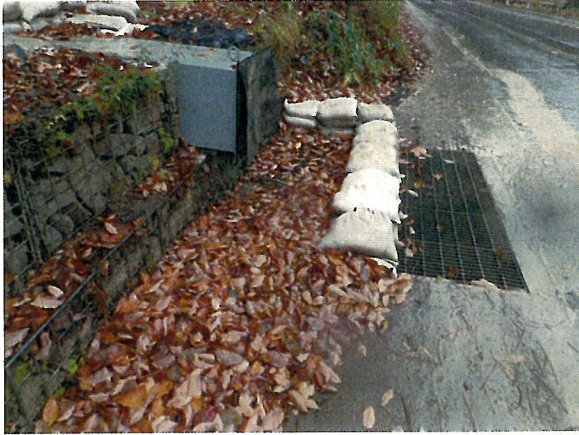
① 3号調節池下流県道沿い排水管 ・冬期除雪の支障にならないよう一部撤去 ・春に再設置する
