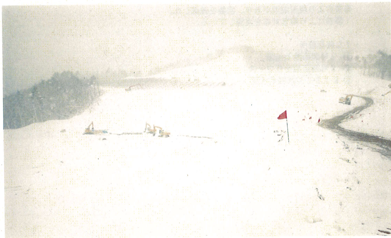
② B-1, B-2 工区積雪状況 ・道路部の除雪実施を確認した。
