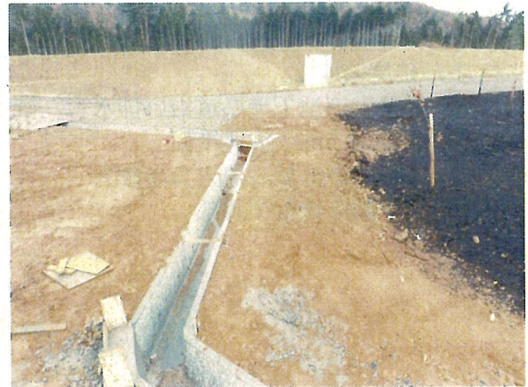
④ 2号調節池脇植栽部 ・造成森林部分に変状ないこと確認
