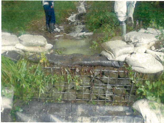
① 3号調節池下流県道部
