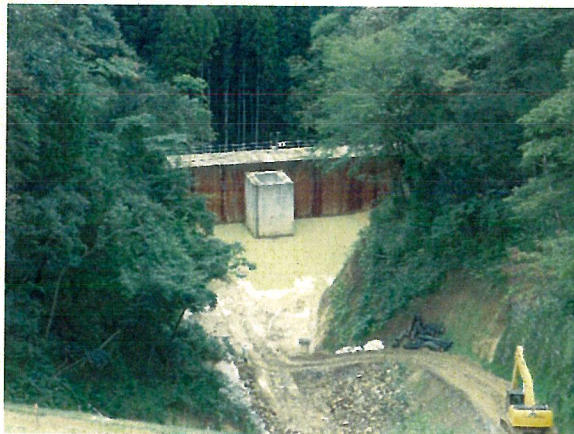
④1号調節池放水塔
