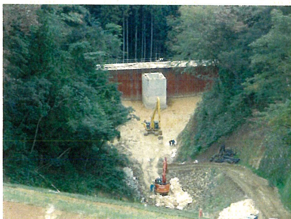
④ 1号調節池放水塔
