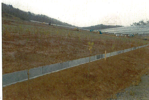
②A 工区植栽状況
