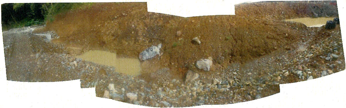
⑤C工区下部の沈砂池
