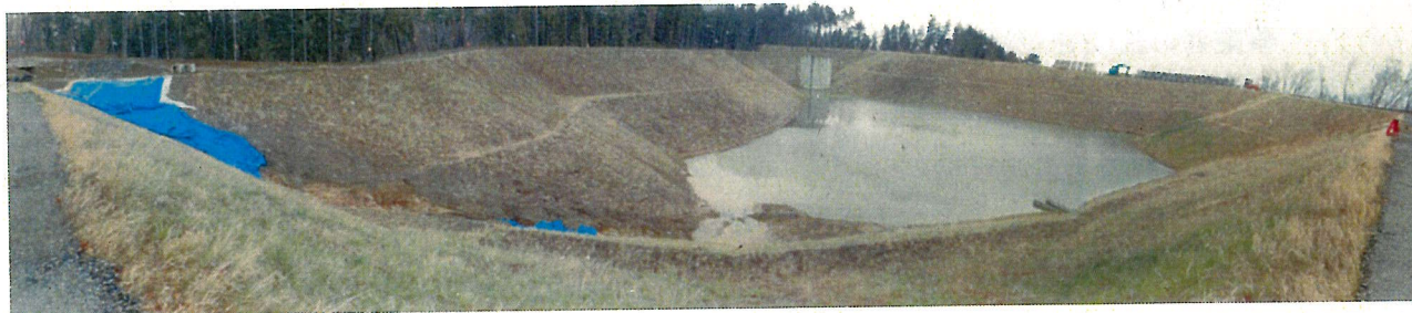
③ 2号調節池現況
