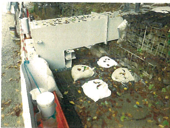
①調節池下流 県道合流部
