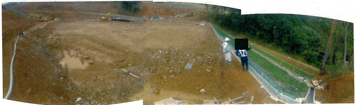
⑦1号調節池上流 高盛土部分
