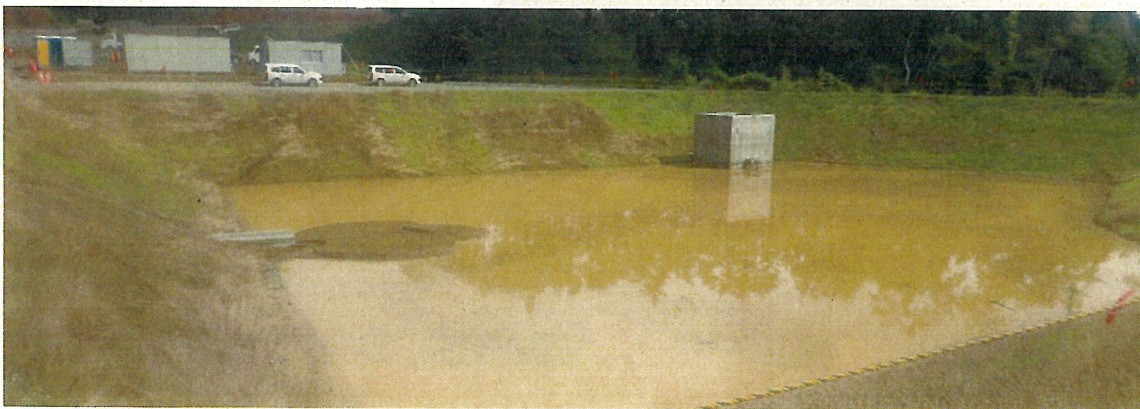
④ 3号調節池上流 補強土壁下部から地上転がし配管の接合部が外れ、沢部洗掘した土砂が流出
