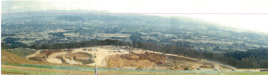
②C 工区遠景 (B-2 工区より)
