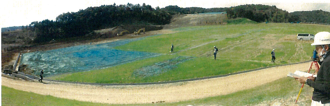
③A-2 工区遠景 (A-1 工区より)
