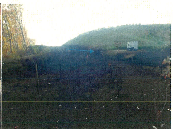
⑥2号調節池隣 (仮沈砂池への導水対策)
