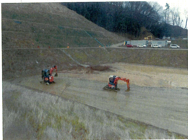
① 3号調節池浚渫状況
