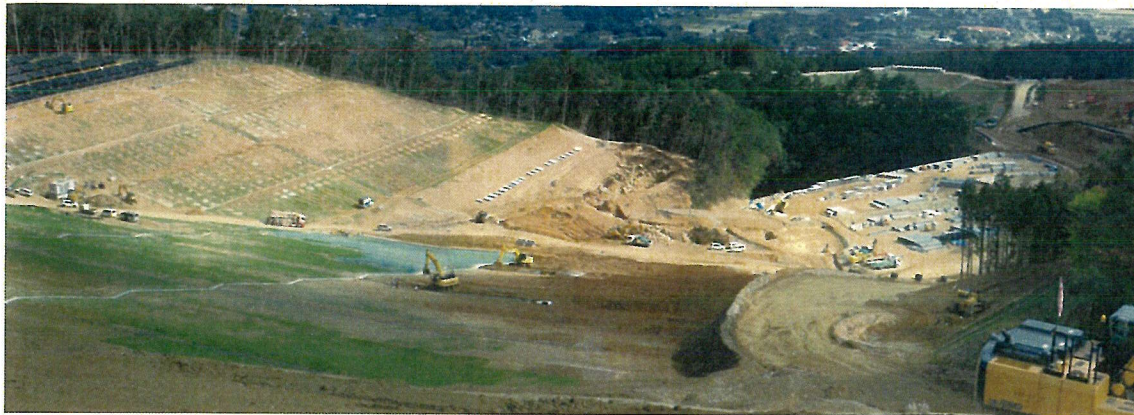
①A-1, A-2 工区遠景 (B-1 工区より)
