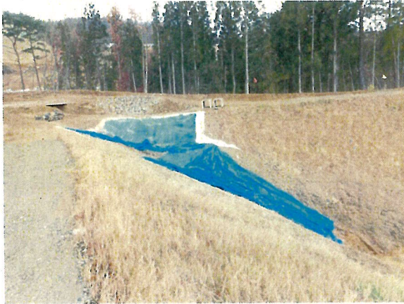
③ 2号調節池仮設流入管の撤去 ・造成の進展に伴い仮設配管を撤去 ・土側溝により調節池に流下している。
