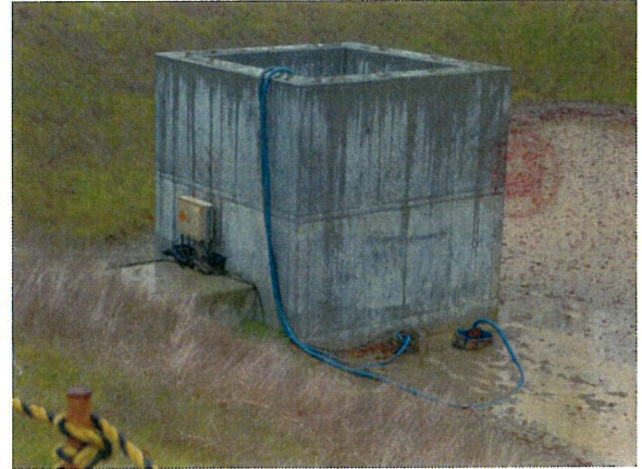
② 3号調節池の浚渫準備 ・ポンプで4日から排水を実施 ・来週以降浚渫を実施する
