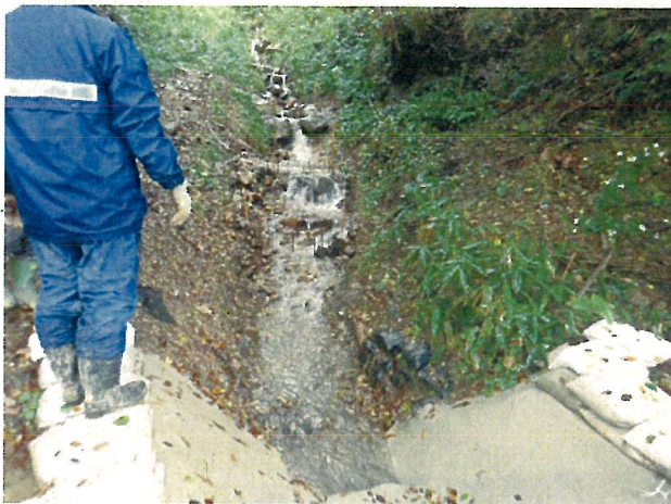
① 3号調節池下流県道沿い仮設
