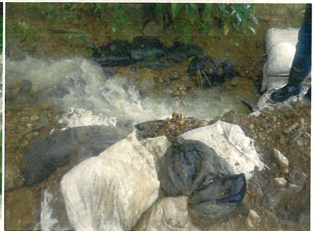
② 3号調節池県道部呑口
