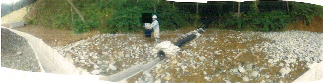
② 2号調節池流入部 配管復旧状況
