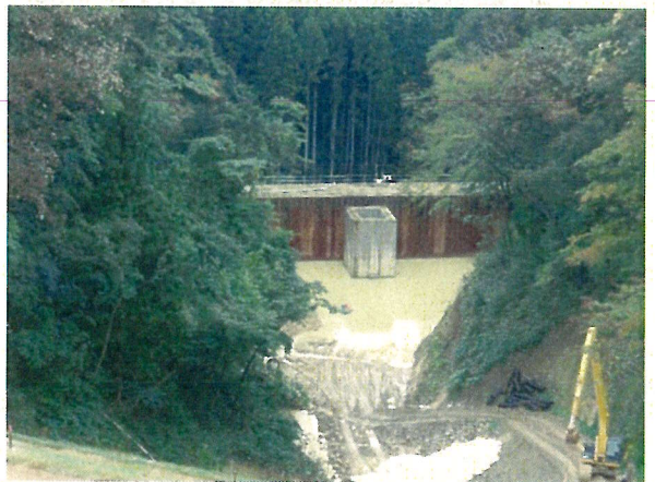
④ 1号調節池放水塔
