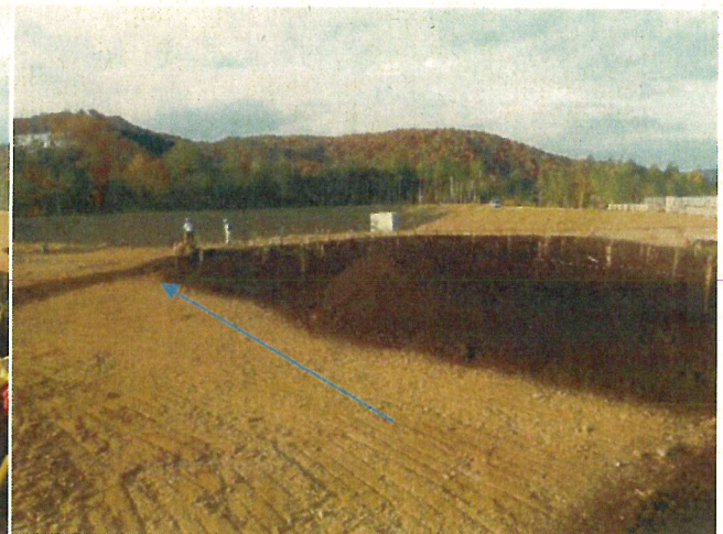
④2号調節池隣 (2号調節池への導水対策)
