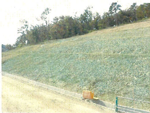
⑤3号調節池脇の法面再吹き付け
