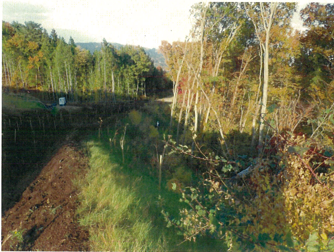
⑦2号調節池隣 盛土部
