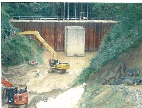
④ 1号調節池放水塔（浚渫中）
