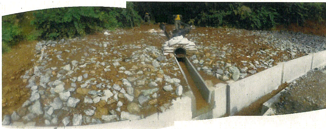
④ 3号調節池上流 補強土壁下部から地上転がし配管の接合部が外れ、沢部洗掘した土砂が流出
